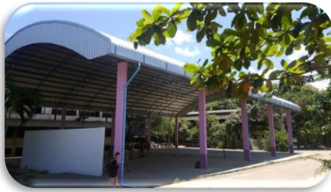
ก่อสร้างอาคารอเนกประสงค์หลังคาโดม
